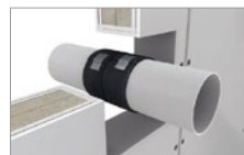
Fertige Wicklung mit Gewebeband fixieren
