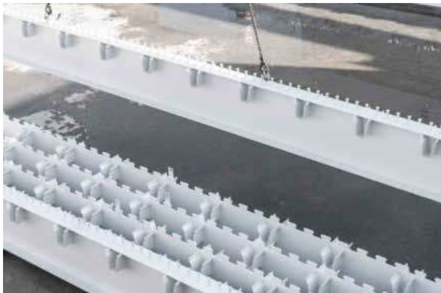
Brandschutzbeschichtungen unterscheiden sich in ihrer Oberflächenoptik nicht wesentlich von anderen Farbanstrichen und können gestrichen, gerollt oder, insbesondere bei filigranen Konstruktionen, im Airless-Spritzverfahren appliziert werden.
